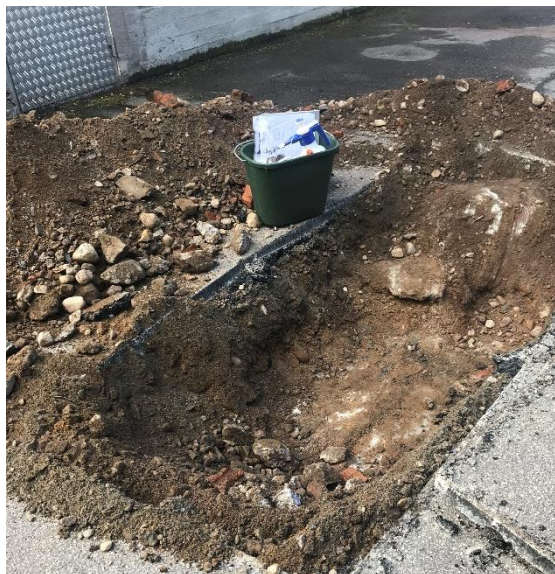
Figur 5. Fyllnadsmassor med inslag av rivningsmassor i provpunkt 2003.
