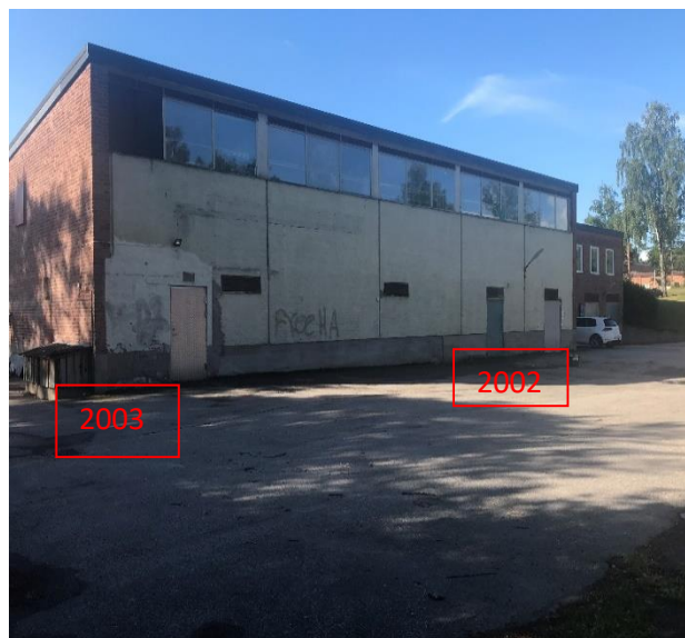
Figur 6. Placering av provpunkt 2002 och 2003, norr och nordväst om f.d. panncentral.
